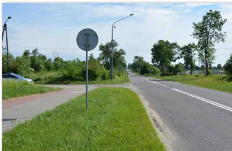
Budowa ścieżki rozpocznie się już we wrześniu
